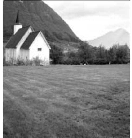
Bildet viser det nye feltet, med kirken i bakgrunnen. I forgrunnen til høyre står en merkestang, som markerer øverste, sørlige, hjørne av det nye feltet. Lengst bak til høyre er det siste gamle feltet, som nå var nærpå fullt.
